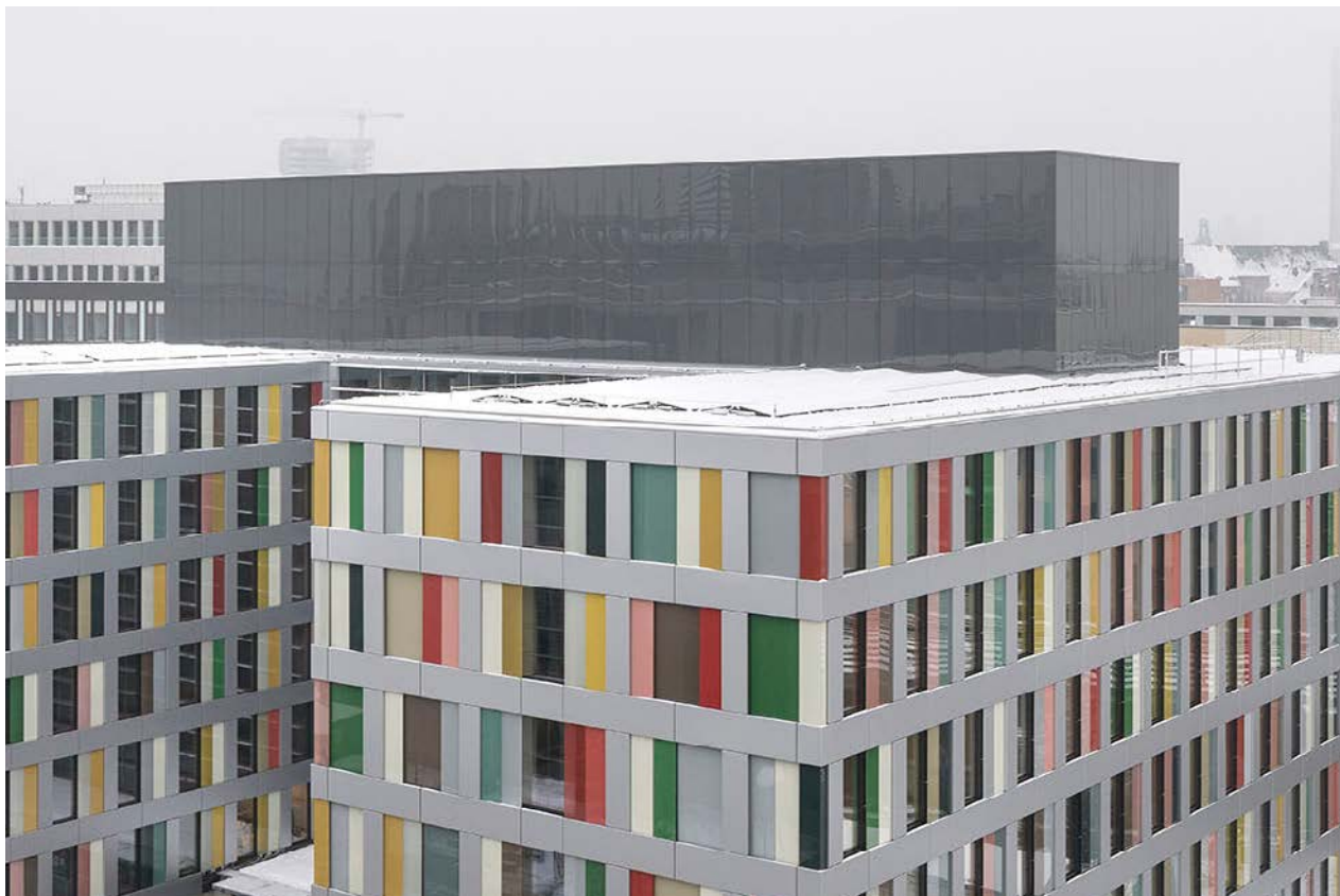
Der Technikraum im Luisenblock in Berlin wurde architektonisch mit einer hinterlüfteten Fassade des Systems GM GLASSICS gestaltet.
