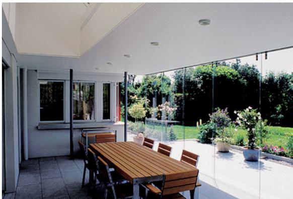
**Transparentes Schiebesystem mit oben hängenden Ganzglasschiebeelementen, nach rechts oder links verschiebbar.**
